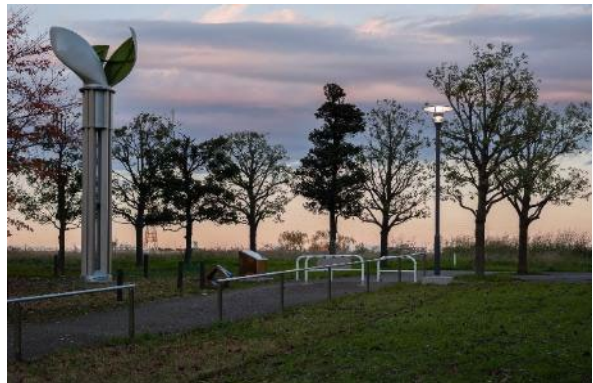
URハートアイランド新田 2019 設計：近田玲子デザイン事務所・UR都市機構 ポール部は既存の再利用、ヘッドのみ新設しました。アルバスルンは光源部のみ交換可能、今後のメンテナンスも最小部材で簡単にできます。
